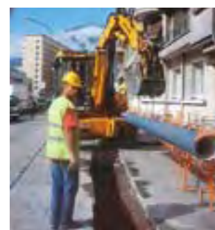
Pose de nouvelles canalisations sur les grands boulevards
