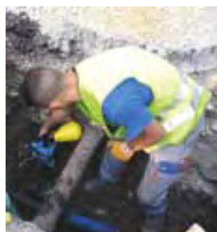
Rénovation d'un branchement
